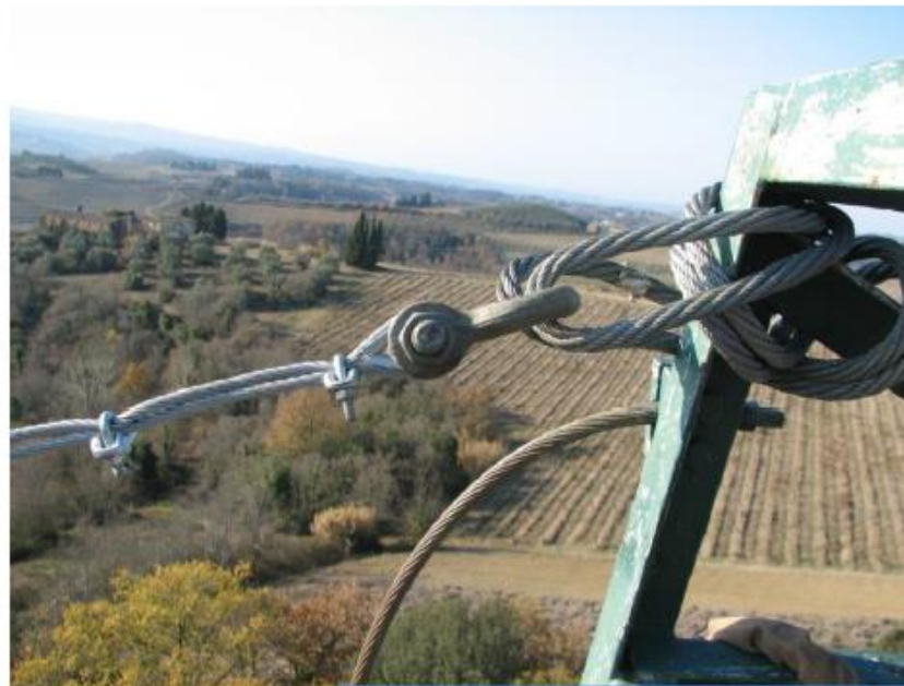
Příklad připevnění s-s lana
