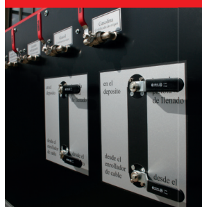
3-Wege Steuerung der Flüssigkeiten
